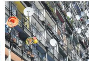
Der Wohnkomplex „Palaisium“ in Schöneberg wird ab Oktober 2025 mit der Abwärme eines nahegelegenen Rechenzentrums der Telekom beheizt.
